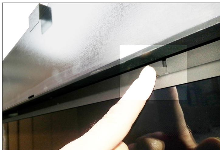
Au dessus de la vitre (en dessous de la baguette supérieure), sont prévus des crochets (à gauche, droite et au milieu). Soulever légèrement avec vos doigts. La vitre peut maintenant basculer sous 45°.
