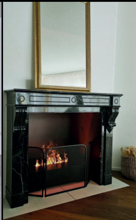
Aufbau einer Cheminée-Feuerstelle Nachher
